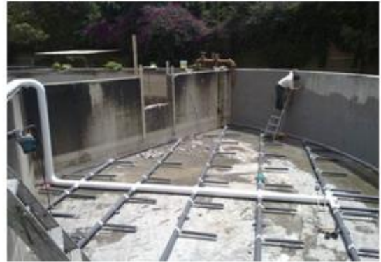
INSTALACIÓN SISTEMA DE AIREACIÓN
