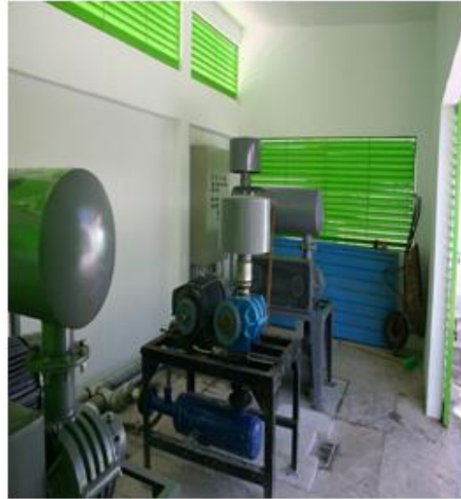
SOPLADORES DE LÓBULOS ROTATORIOS DE 20 H.P.
