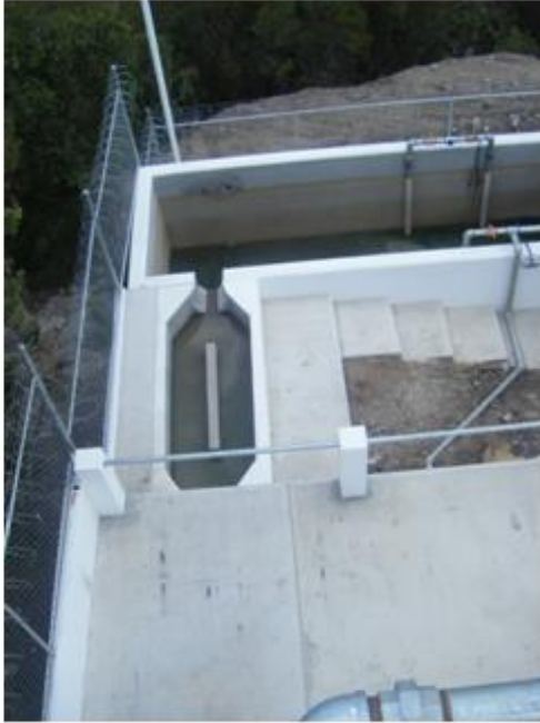
CANAL DESARENADOR Y CÁRCAMO DE BOMBEO
