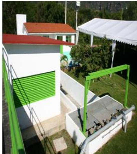
CASETA DE CONTROL CANAL DESARENADOR Y CÁRCAMO DE BOMBEO
