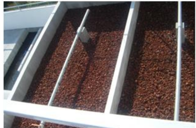
LECHOS DE SECADO DE LODOS
