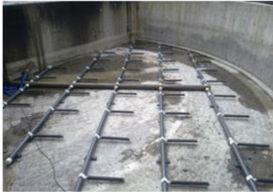
INSTALACIÓN SISTEMA DE AIREACIÓN
