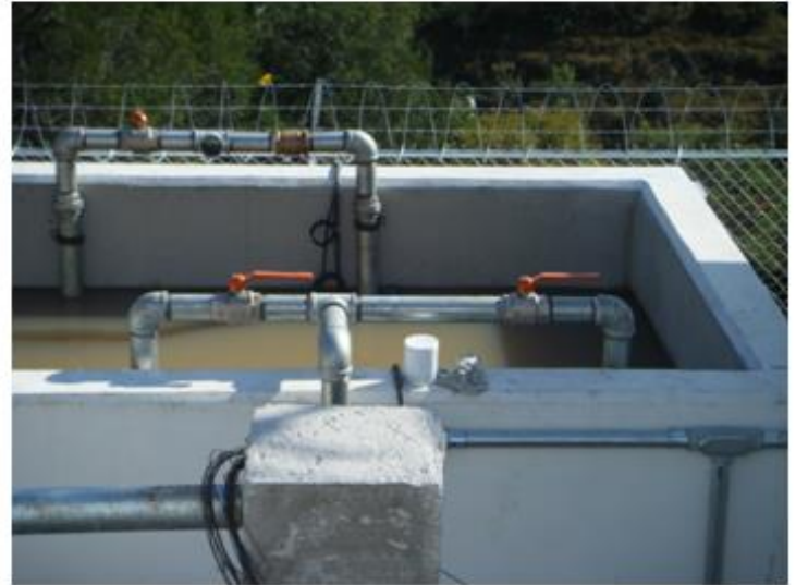
CANAL DESARENADOR Y CÁRCAMO DE BOMBEO
