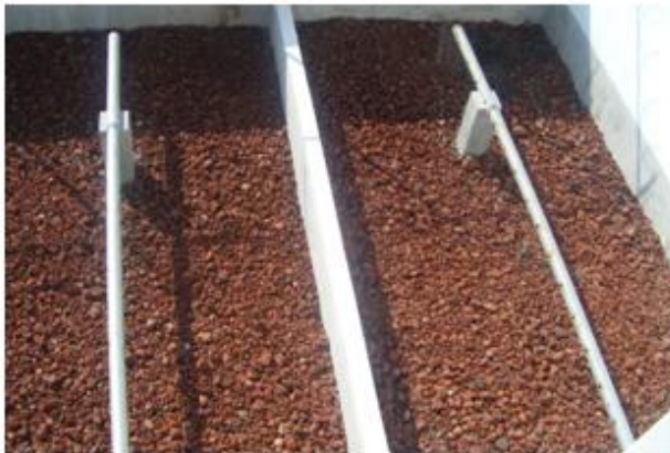
LECHOS DE SECADO DE LODOS
