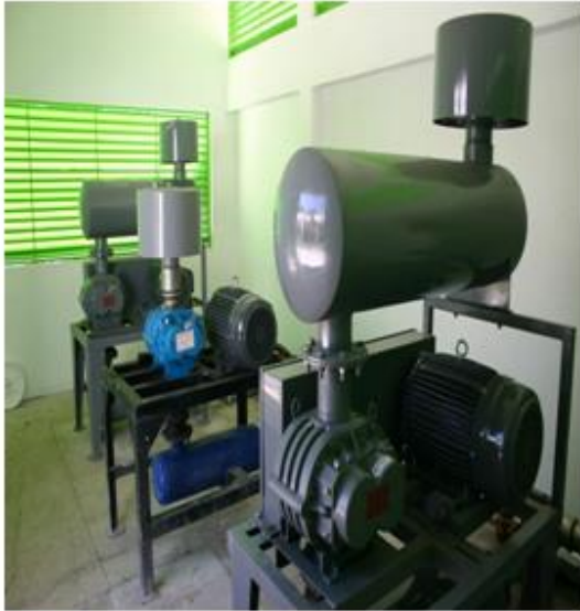
SOPLADORES DE LÓBULOS ROTATORIOS DE 20 H.P.
